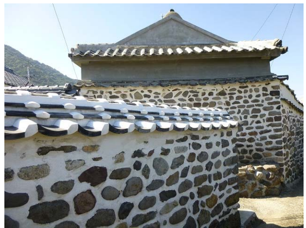
図4 屋根と一体となった練塀
