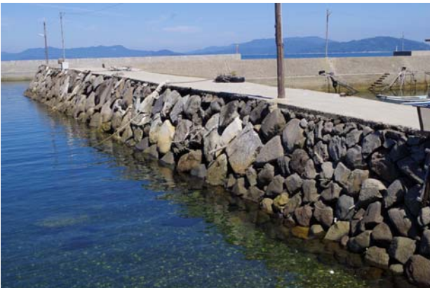
図 11 「石垣」で紹介されていた突堤
