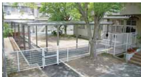
女子寮の玄関(左奥)まで渡り廊下と屋根ができました。
