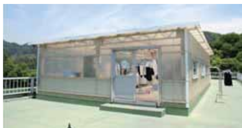
洗濯場:屋上にあります。
