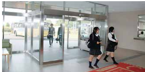
玄関ホール：自動ドアの風除室ができました。
