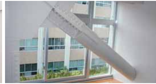
教員研究室：窓際に耐震ブレースが入りました。
