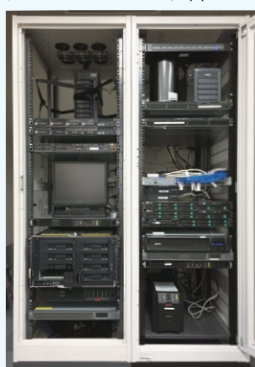
サーバコンピュータ群
