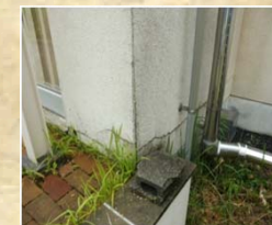
外壁劣化状況(クラック)
