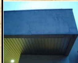
玄関底の剥離
