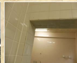
浴室タイルの剥離
