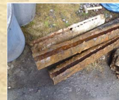
厨房排水管腐食
