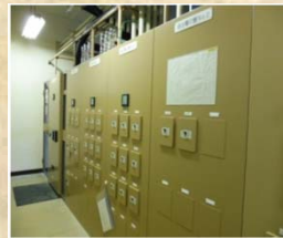
低圧配電盤更新
