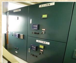
高圧配電盤更新
